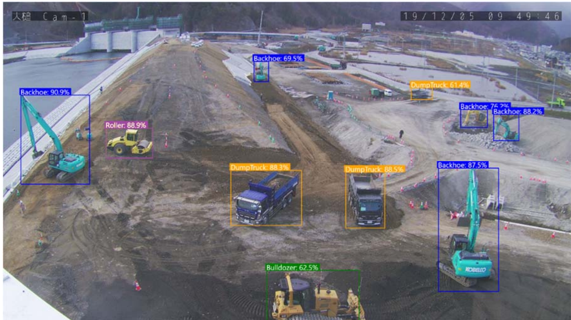
図 5 AI によるダンプおよび建機の識別結果 (概ね 80% の識別率)
