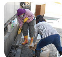
台風18号風水害復旧支援の様子
