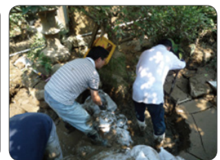
山口県豪雨災害復旧支援の様子
